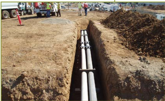
Conduits Installation in Elk Grove
