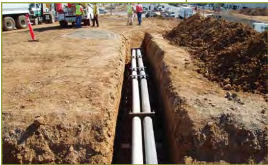
Conduits Installation in Elk Grove
