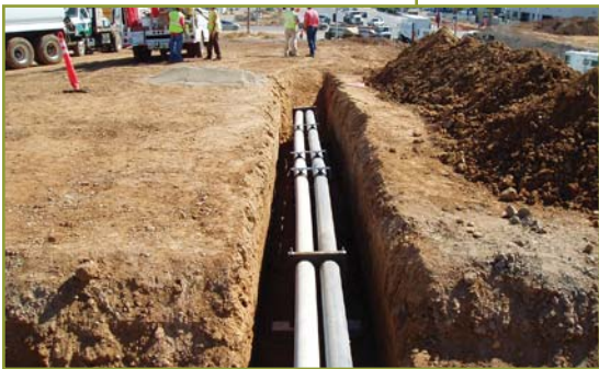
Conduits Installation in Elk Grove
