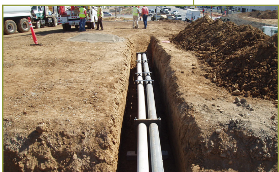
Conduits Installation in Elk Grove
