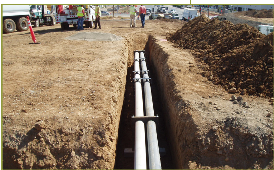
Conduits Installation in Elk Grove
